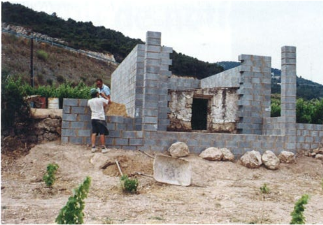
Treballs de construcció de l'actual caseta protectora del forn de Fontscaldes. (Foto: Samuel Burguete)
