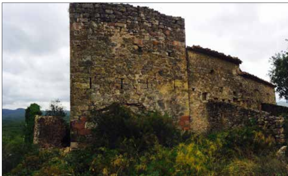
Figura 7. Façana nord de la masia.
