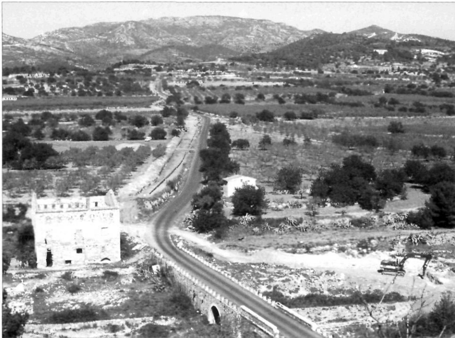
Fig.1. Vista general de la zona de Pont de Goi
